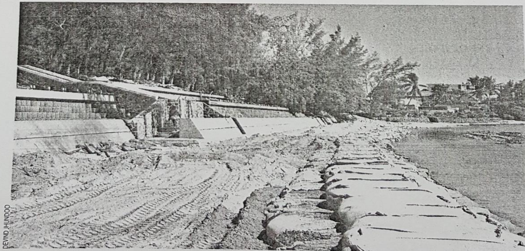
Les travaux de protection de la plage de Bain-Boeuf visent à empêcher le sable de s'effondrer. La plage sera ensuite renflouée.
