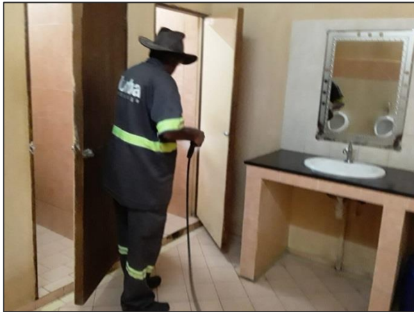
Toilet Block at Bras d'Eau public beach
